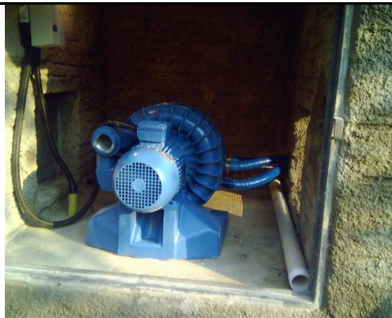
Compressor de 5 cv – 2000 l/min
